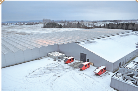
広大な屋内栽培施設
